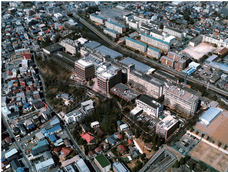
創想館完成時の矢上空撮（南東から）
