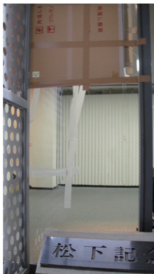
地震によるひび割れ
