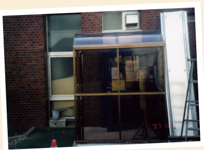
創想館新築工事中の仮設出入口
