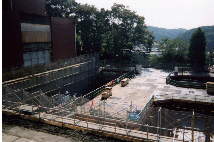
25棟から見た創想館工事現場 (左に図書館)
