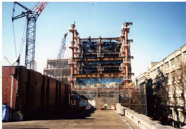
図書館屋上から組みあがった鉄骨を見上げる
