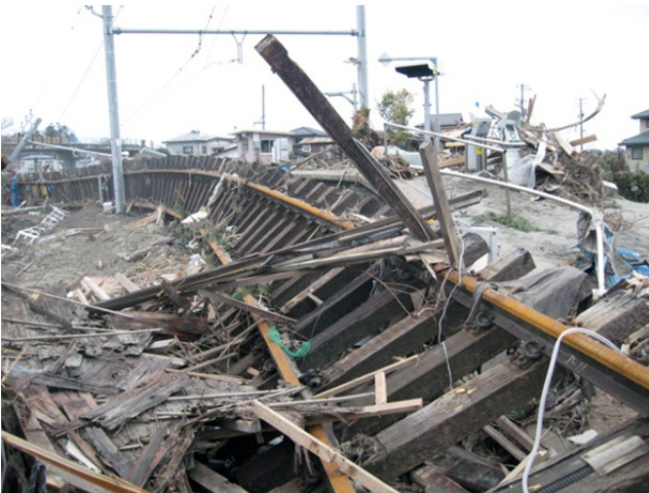
図 7-51 破壊された JR の線路
