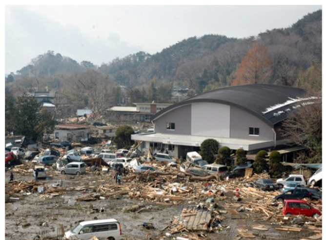
図 7-54 体育館の周囲に溢れる瓦礫
